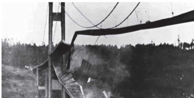
Imagem: O desabamento da ponte.
